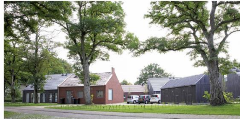
> Erf-achtige opzet van nieuwbouw, Brinkwonen, Schoonoord. Hoofdgebouw van baksteen. Schuurachtig gebouw van zwart hout minder prominent op de kavel. Schoonoord, Brinkwonen, Buro Harro/AAS
